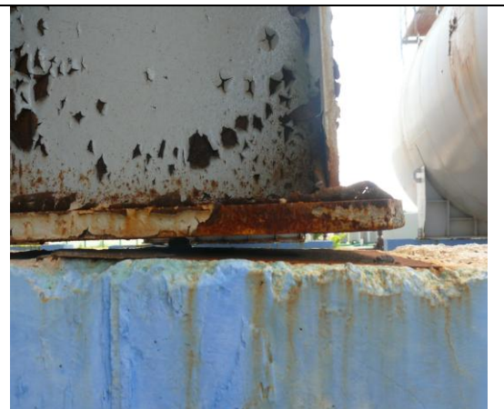
Fig. 4. Idem a la anterior, aunque la separación hace que sea más propio de un área inaccesible. Aplicar mástique.
